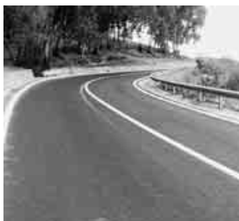
UN TRATTO DELLA STRADA RIAMMODERNATA
